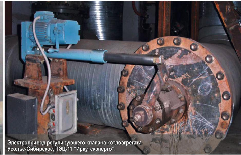
Электропривод регулирующего клапана котлоагрегата. Усье-Сибирское, ТЭЦ-11 "Иркутскэнерго".
