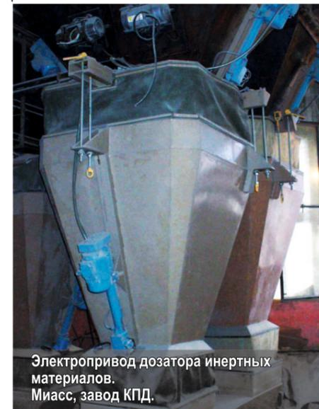
Электропривод дозатора инертных материалов. Миасс, завод КПД.
